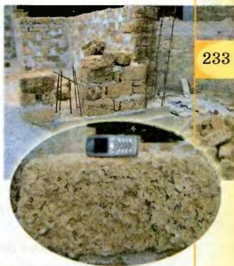
Рис. 203. Ракушечник – строительный материал
