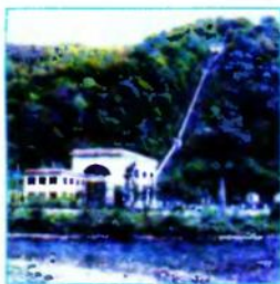
Мал. 175. Тербле-Ріцька ГЕС. Побудована на р. Ріка, а турбіни приводить у рух вода Вільшанського водосховища на р. Тербля, яка бетонним тунелем перетинає гірський хребет і падає з висоти близько 200 м
