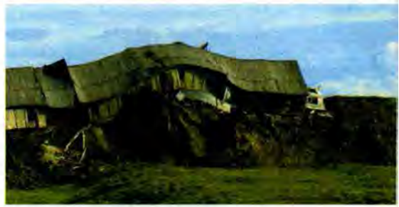
Мал. 71. Будівля, розташована в долині Єнісею, була зруйнована внаслідок танення підземного льоду
