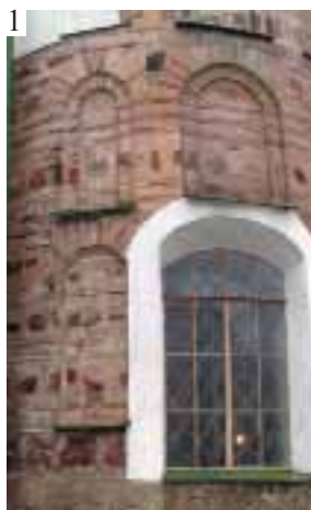
1. Fragment ściany soboru św. Zofii. Ściany soboru wyłożono z dużych przyrodniczych kamieni – granitu i różowego kwarcytu, których bryły zmieniały się z szeregiami płytkiej cegły – plinty..
