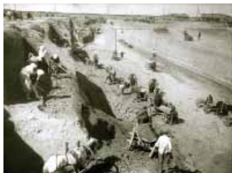
Wywożenie gruntu z wykopu na budownictwie Dnieprzańskiej elektrowni. 1930 r.
