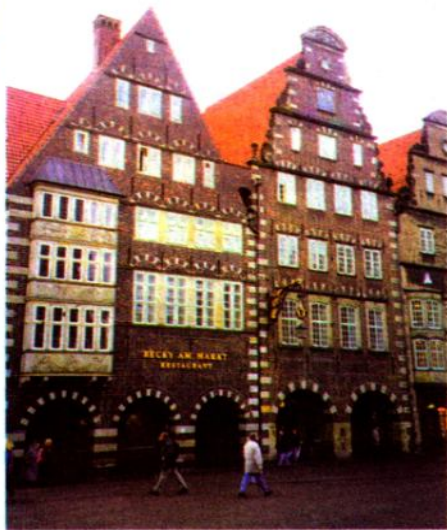
Рис. 195. Крутые крыши домов в Германии (г. Бремен)
