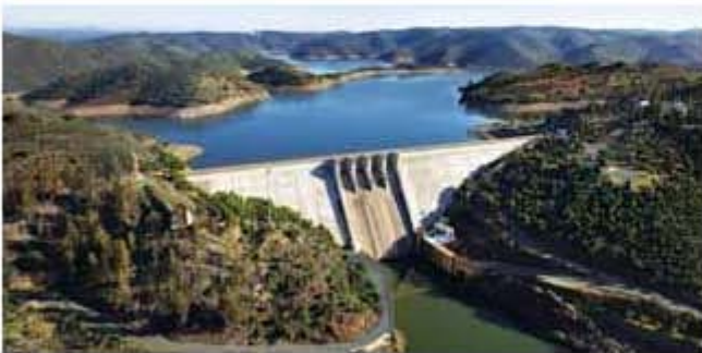
Рис. 242. Образование водохранилища на реке
