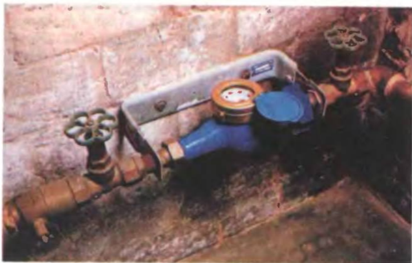
Мал. 49. Такий вигляд має вентиль, що перекриває водогін
