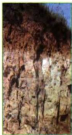
Рис. 12.6. Відслонення лесоподібних суглинків (у верхній частині — ґрунт)
