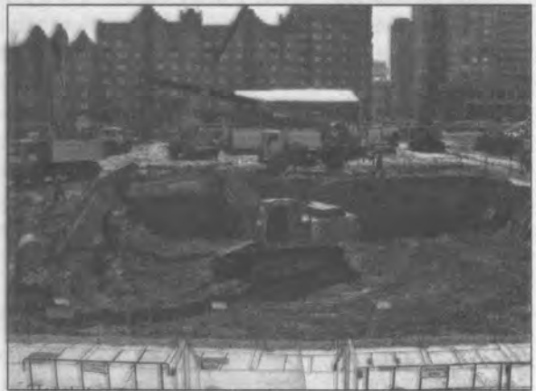
Мал. 19. Будівництво будинку
