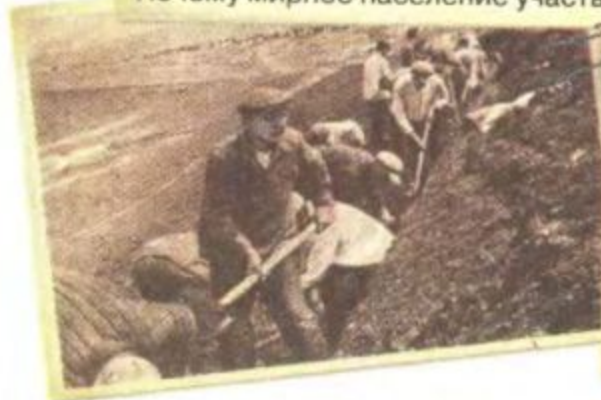
Сооружение оборонных укреплений под Киевом. 1941 г.
