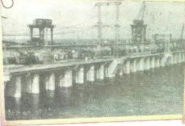
Плотина Кременчугской ГЭС. 1960 г.
