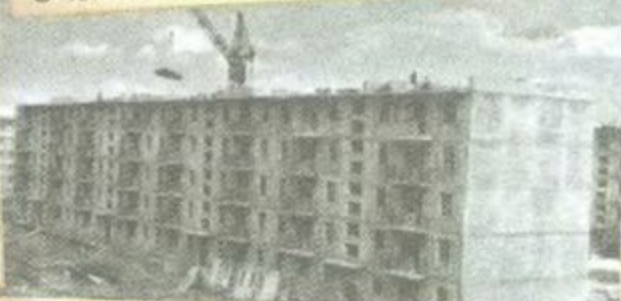
Строительство «хрущёвок». Киев, начало 60-х годов
