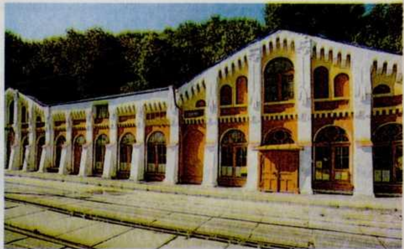
Машинний будинок нижньої станції водогону в Києві. 1870–1872 рр. Інженер А. Струве
