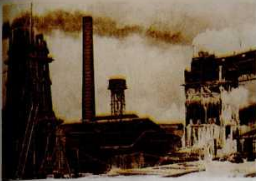
Будівництво доменної печі на металургійному заводі в Макіївці
