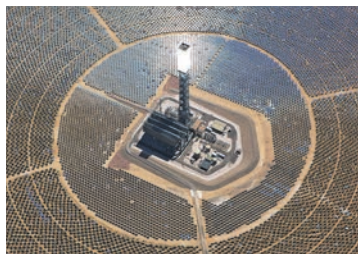
Рис. 10. Одна из крупнейших солнечных электростанций в мире — «Айванпа» (США, Калифорния). 173 тыс. зеркал отражают солнечный свет и направляют его на вершины трех башен, где установлены котлы с водой. Горячий пар поступает на лопасти турбин, установленных в башнях
