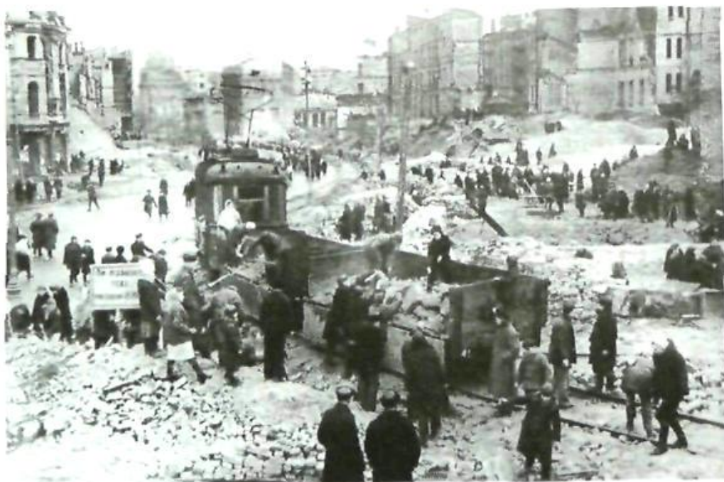
Київ на відбудові вулиці Хрещатик, 1944 р.
