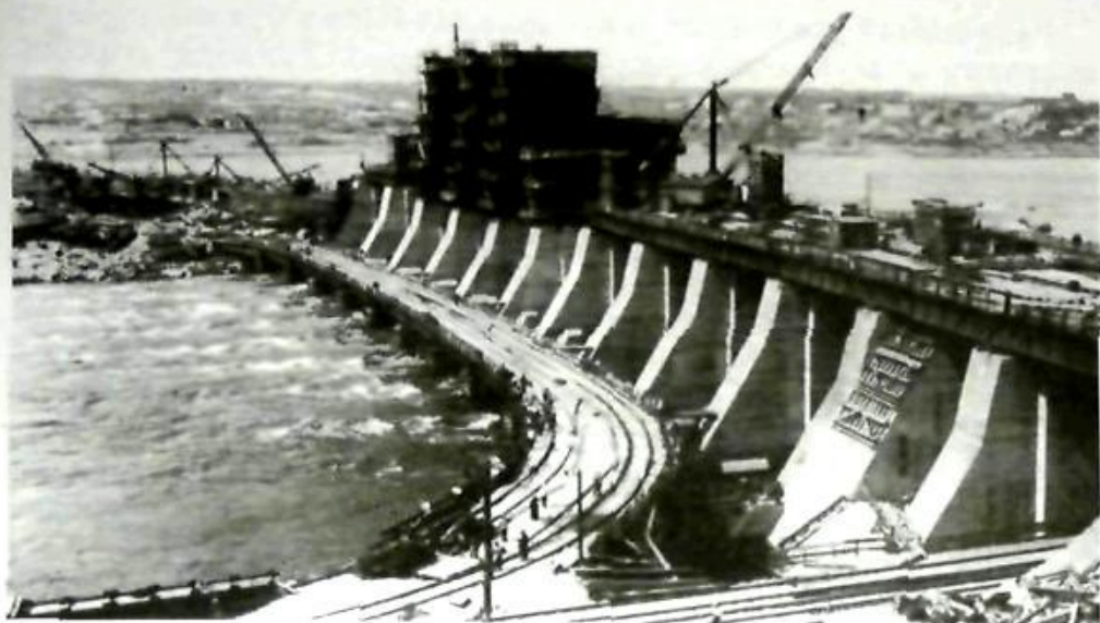
Будівництво Дніпрогесу – Дніпровської гідроелектростанції ім. В. Леніна. 1929 р.
