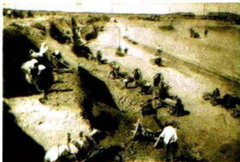
Вывоз земли из котлована на строительстве Днепровской ГЭС. 1930 г.
