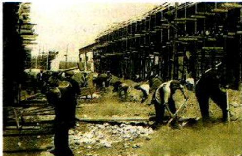
Строительство механического цеха № 6 на Новокраматорском машиностроительном заводе. 1932 г.
